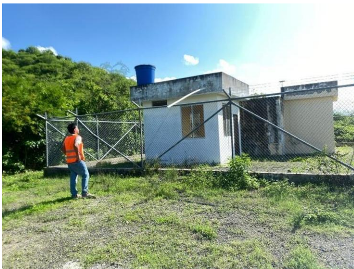
Figura 4.2. Infraestructura comunitaria para almacenamiento y distribución de agua
