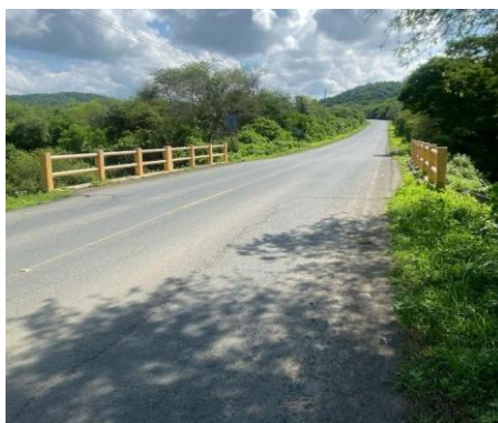
Figura 5.2. Puente en la vía de acceso a Joa
